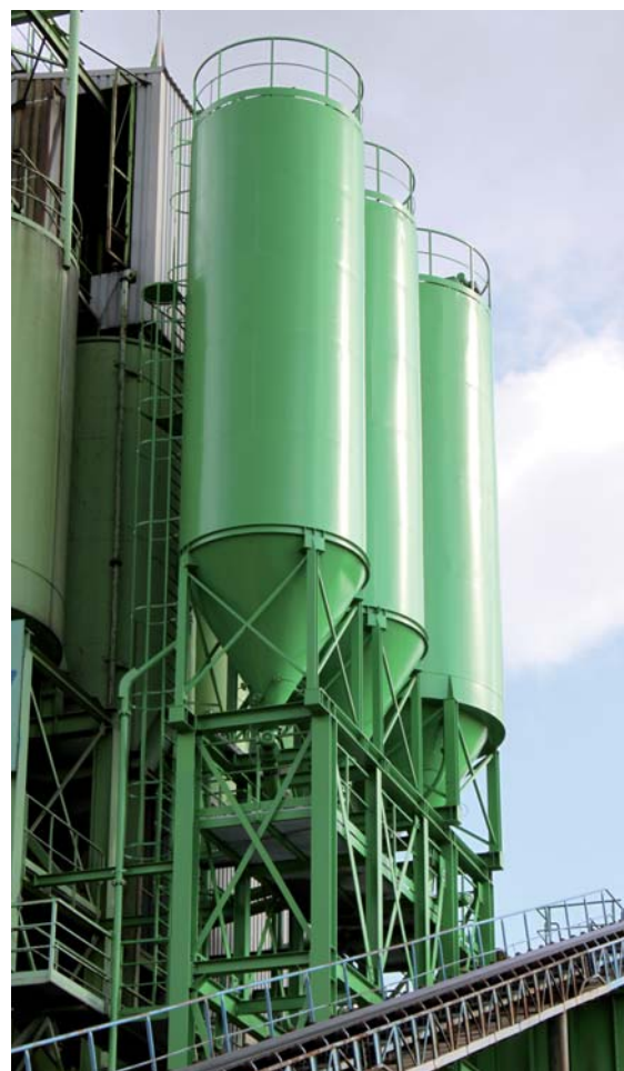
Afb. 4 De renovatie en uitbreiding van een silopark in de betonindustrie
