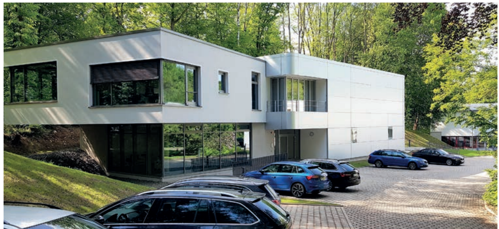
Afb. 4 Jehmlich test- en applicatiecentrum in Nossen (Duitsland)
